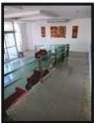
Rampas de acesso
